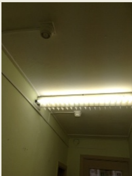
Коридоры раздевалок до ремонта
