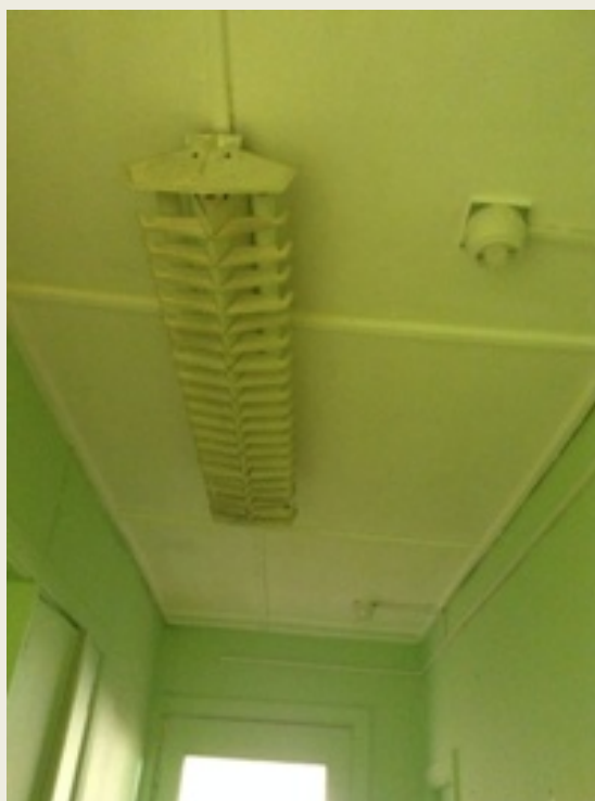
Коридоры раздевалок после ремонта
